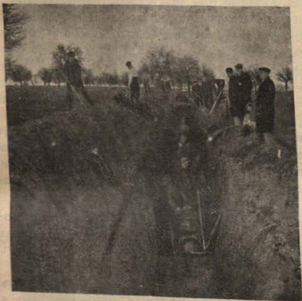
Копане на водопровода
