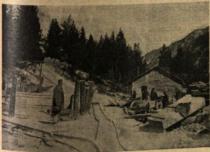
Началото на Рилския водопроводъ
