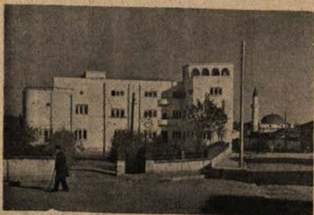
Добричъ. Зданието на пощата.
