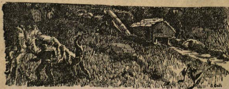
На работа — подъ дънера при старата воденица.
