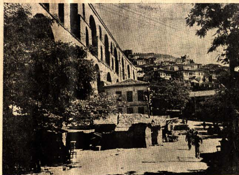
Градъ Кавала съ голѣмата стена на водопровода. Единъ отъ красивитѣ градове край Бѣло-море.
